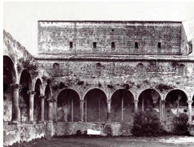
Chiostro di S. Maria del Riposo prima dei restauri del 1971
